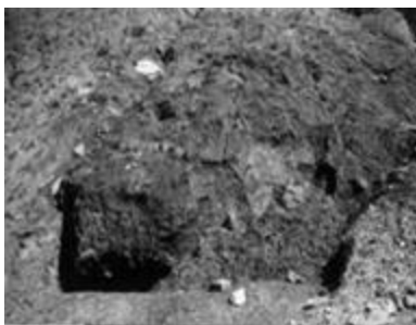
图 5 滑坡发生后照片
